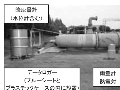
図 2. 2. 3. 4 測定機器設置状況
