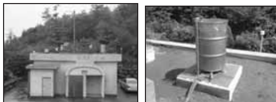
図 2.2.3.28 観測局舎上設置状況(野尻地点)
