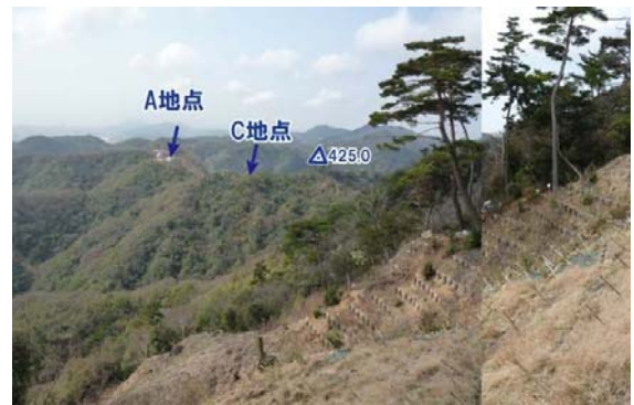
図－2 受信制御装置周辺からの見通し
