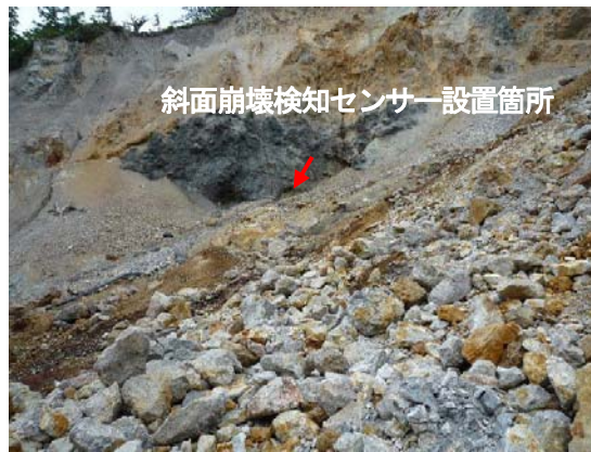
図 4.1 落石等による誤検知の可能性がある場所に設置した事例
