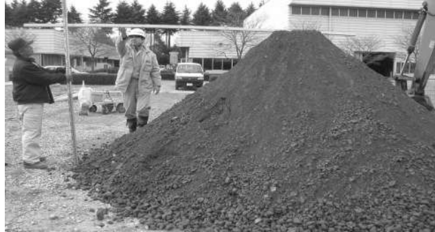
図-1 センサーを埋設した盛土(高さ 185cm) 状況
