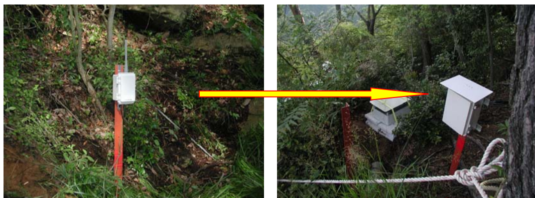
写真—2 タイプIVセンサー・無線受信ロガーの設置状況（苧川谷試験フィールド）
