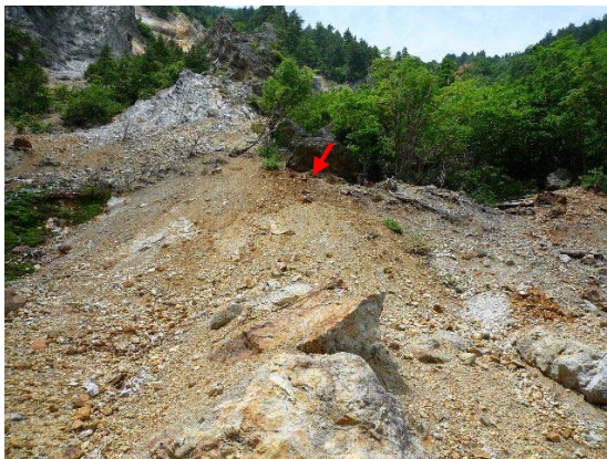
図-1 タイプⅢセンサー設置場所①
