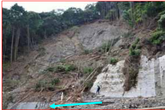
崩壊した斜面の下部に堆積する流木
