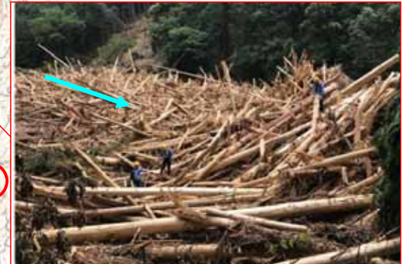
須川第一砂防堰堤に堆積する流木
